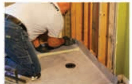
Install sheet membrane.
